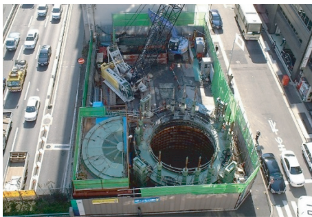
写真3 施工現場 Photo 3 Construction site
